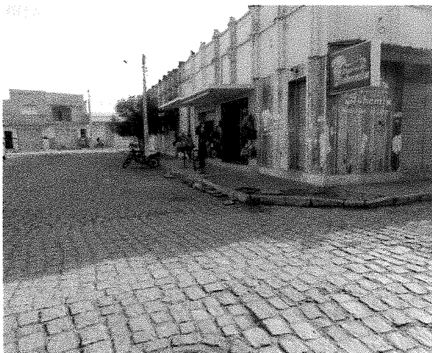
FOTO 3: CALÇADA RUA S.D.O
