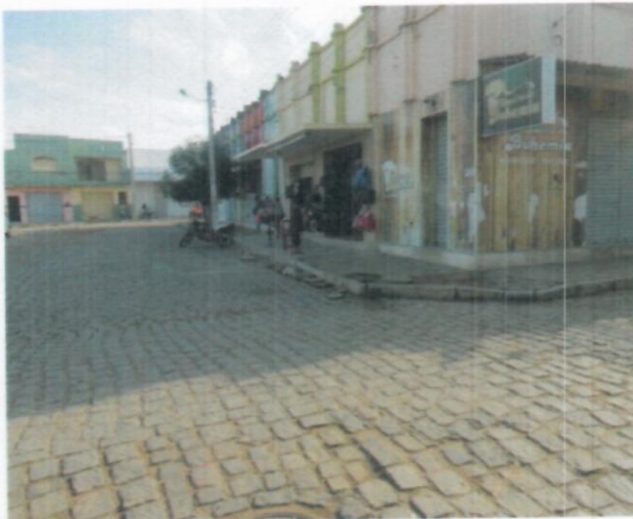
FOTO 3: CALÇADA RUA S.D.O
