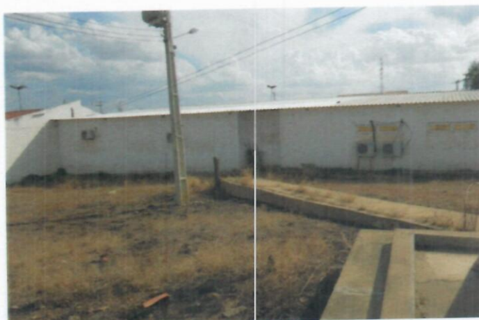
Figura 10 - FUNDOS DO BLOCO SALA DE AULA
