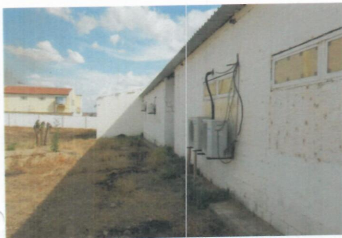
Figura 8 FUNDOS DO BLOCO SALA DE AULAS
