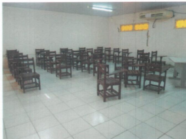
Figura 13 - RACHADURAS NAS PAREDES
