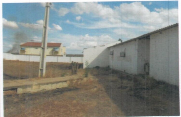
Figura 9 - RACHADURAS AO LONGO DA ALVENARIA
