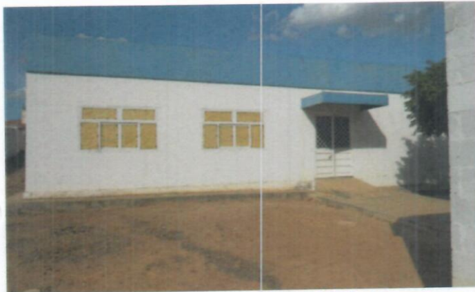
Figura 6 - FACHADA BLOCO SALA DE AULAS
