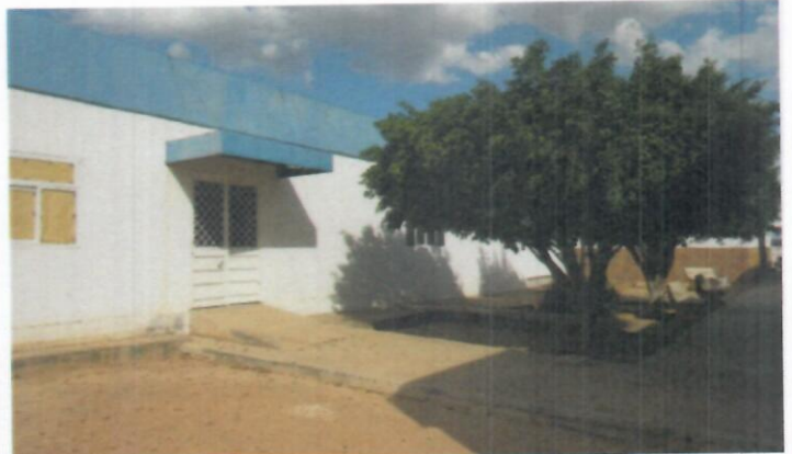
Figura 7 - FACHADA BLOCO SALA DE AULAS
