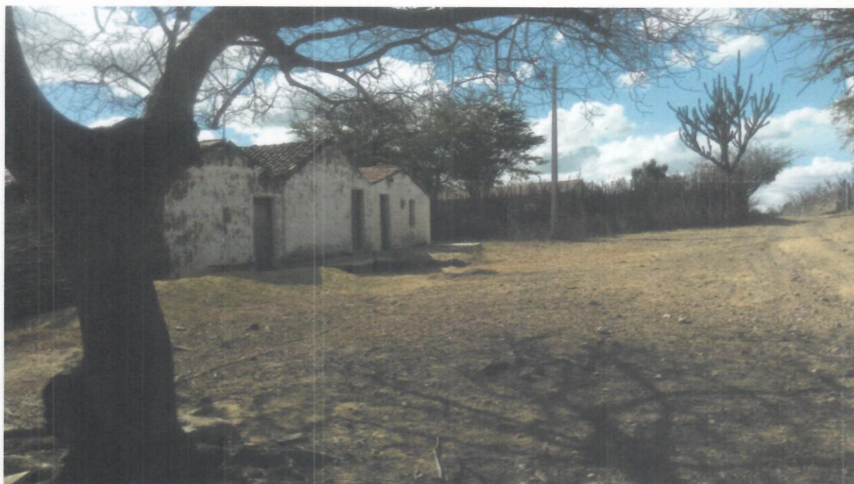
REDE DE DISTRIBUIÇÃO
