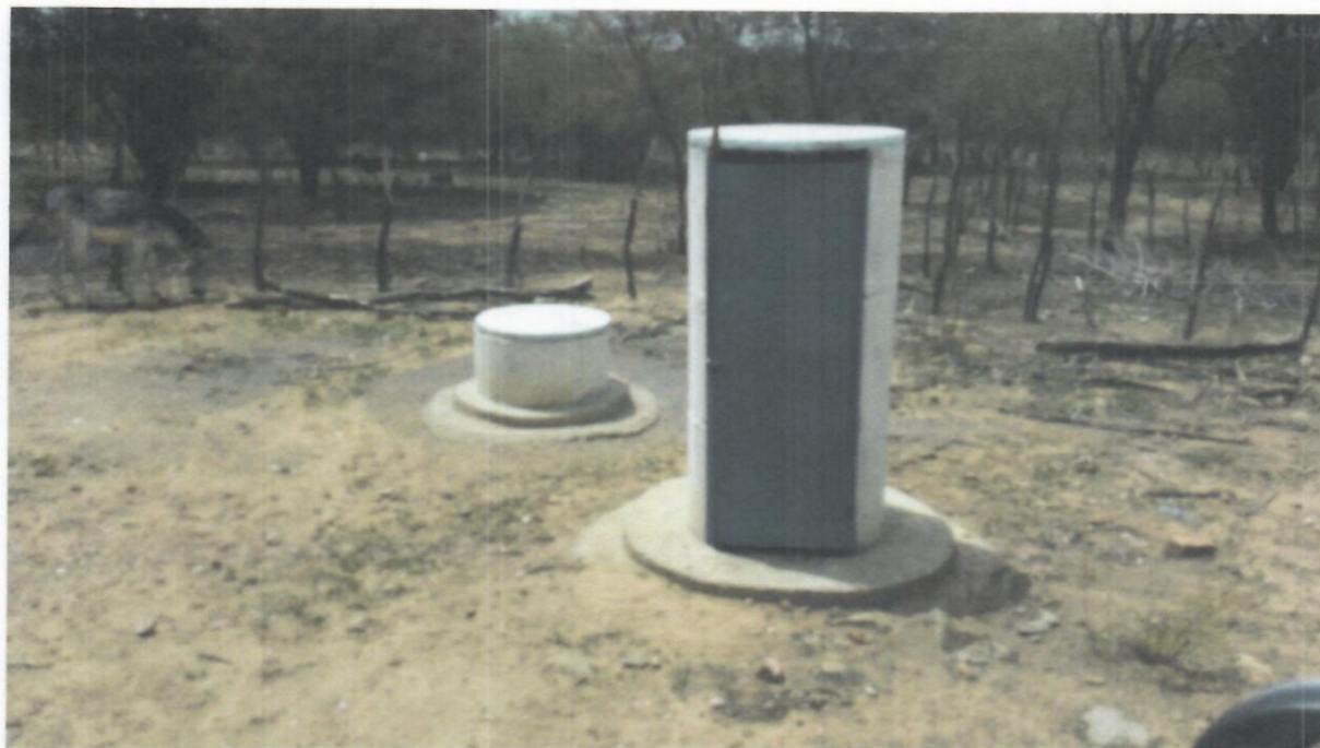
LOCAL DO POÇO EXISTENTE
