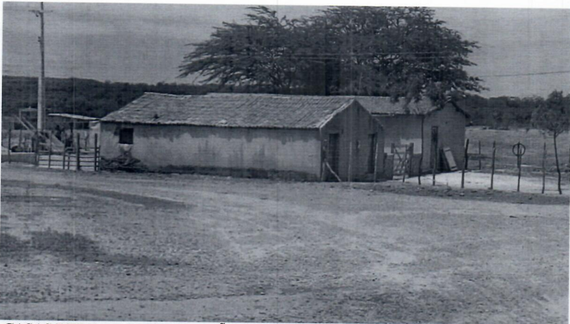
CASAS REDE DE DISTRIBUIÇÃO NO TRECHO 7 (UTM24:347859mE;9224373mN)
