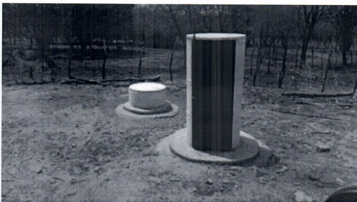
LOCAL DO POÇO EXISTENTE (UTM24: 347566mE ; 9224116mN)
